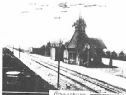
Empfangspavillon des Kaisers
