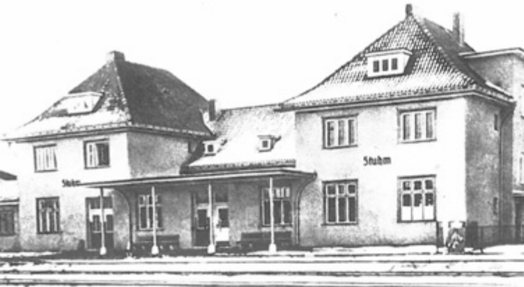
Der in den dreißiger Jahren umgebaute Bahnhof Stuhm.
