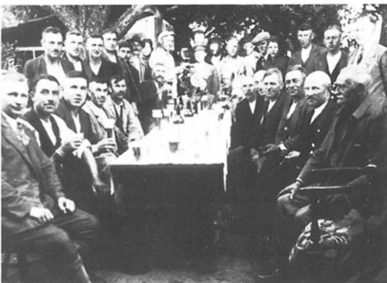
Richtschmaus mit den Handwerkern der Baufirma A. Hildebrandt, Baumgarth.
