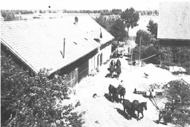
Blick auf den Hofplatz; links der Getreidespeicher, darunter Wagenschauer; dahinter der Schweinestall, rechts der Rinderstall.
