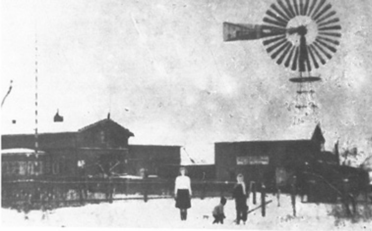
Im Kreis Stuhm gab es schon vor dem II. Weltkrieg „alternative“ Energiequellen; hier das Windrad, das die Mahlmühle des Hofbesitzers Liedtke in Usnitz antrieb. Aufnahme 1940. Solche Windräder, von denen es mehrere im Kreise gab, dienten auch zur Wasserversorgung in Stall und Haus.
