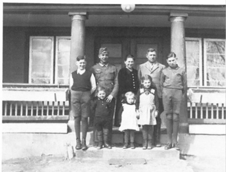
Familie Fritz Strich vor der Veranda mit den hölzernen Säulen.
