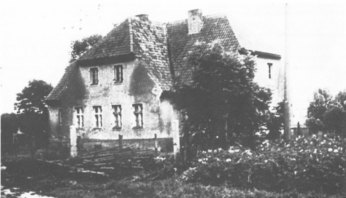
Die in den 30er Jahren erbaute vorbildliche Schule im jetzigen Zustand. Aufn. 1964.
