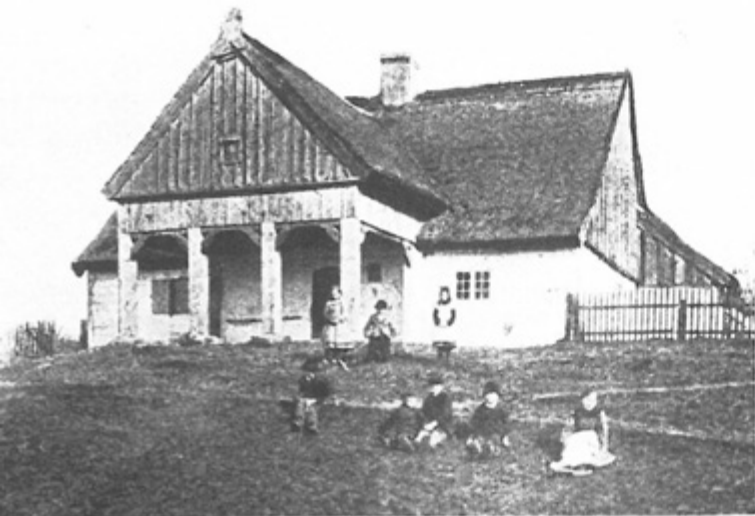
Ältestes Vorlaubenhaus von Altmark. Die Vorlaube befindet sich an der Traufenseite des Hauses.
