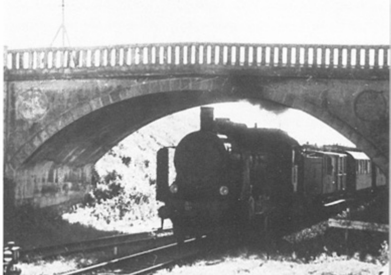
Straßenbrücke am Bahnhof Christburg, Straße nach Altstadt.
