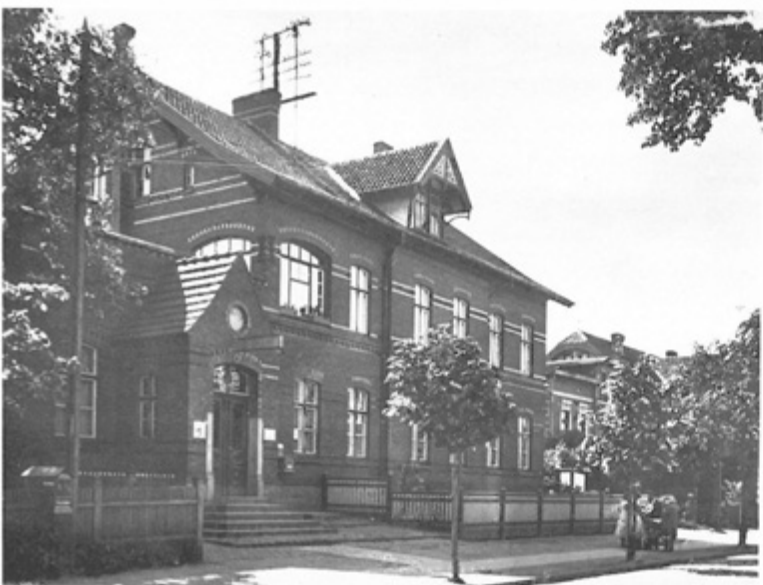
Das Postamt Stuhm in der Hindenburgstraße, erbaut 1885.
