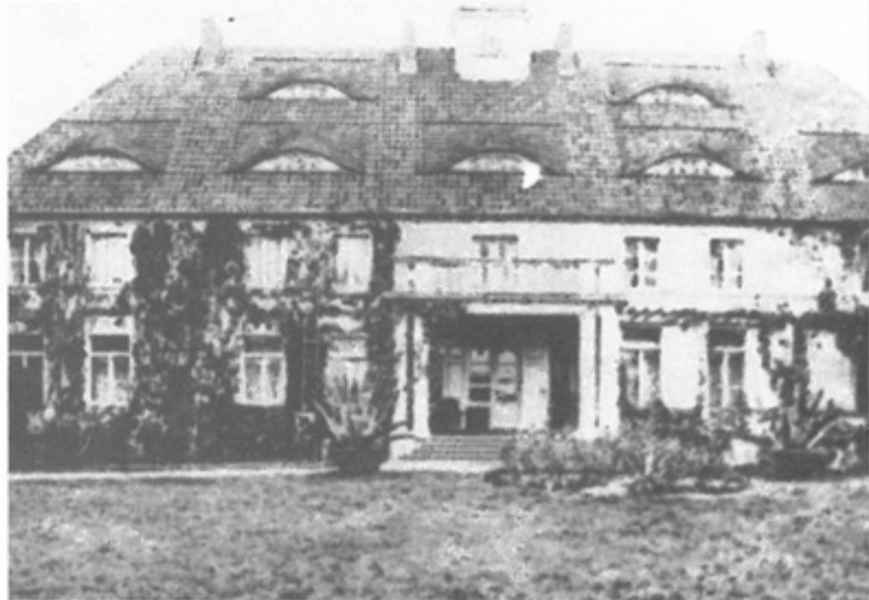
Gutshaus des Rittergutes Groß Teschendorf, Besitzer Gerhard Randolf. Heute sitzt die Direktion der Staatsgüter Teschendorf, Linken, Stangenberg und Baalau in dem Gutshaus.
