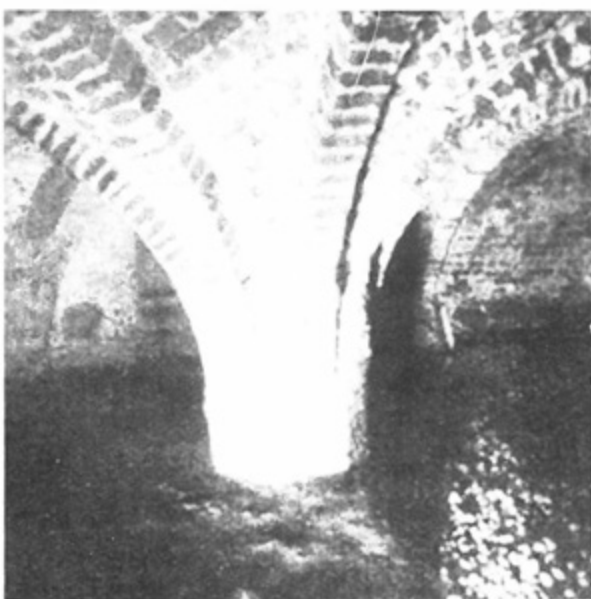
Pfeiler im Gewölbe aus mittelalterlichem Mauerwerk im westlichen Teil des Waisenhauses. Die Kellerräume wurden zu deutscher Zeit wirtschaftlich genutzt, heute dienen sie — unter dem Museum — als Feierraum.
