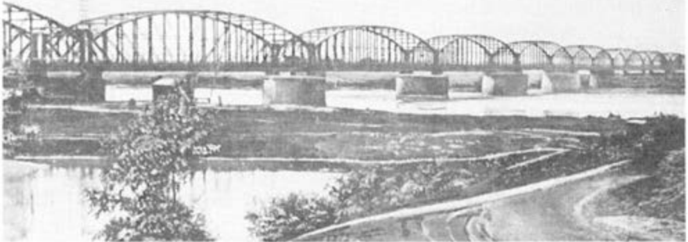
Die Graudenz Weichselbrücke - Eisenbahn- und Straßenbrücke
