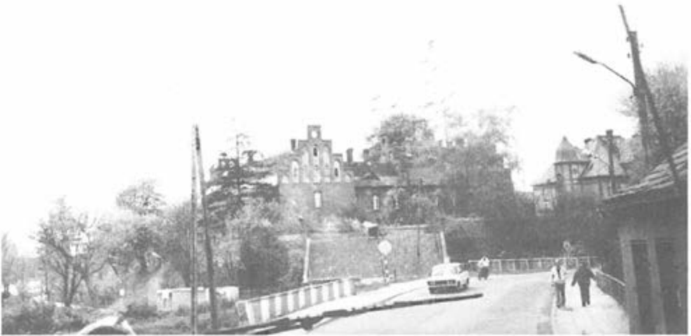
Vom Vorschloß aus Einfahrt nach Stuhm, links ein Rest der Burg
