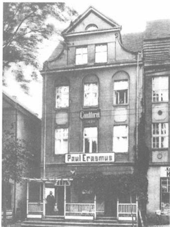
Conditorei - bis 1931 Paul Erasmus, dann Rahn - 1945 nach der Zerstörung ist das Haus Nr. 19 als einziges stehen geblieben.
