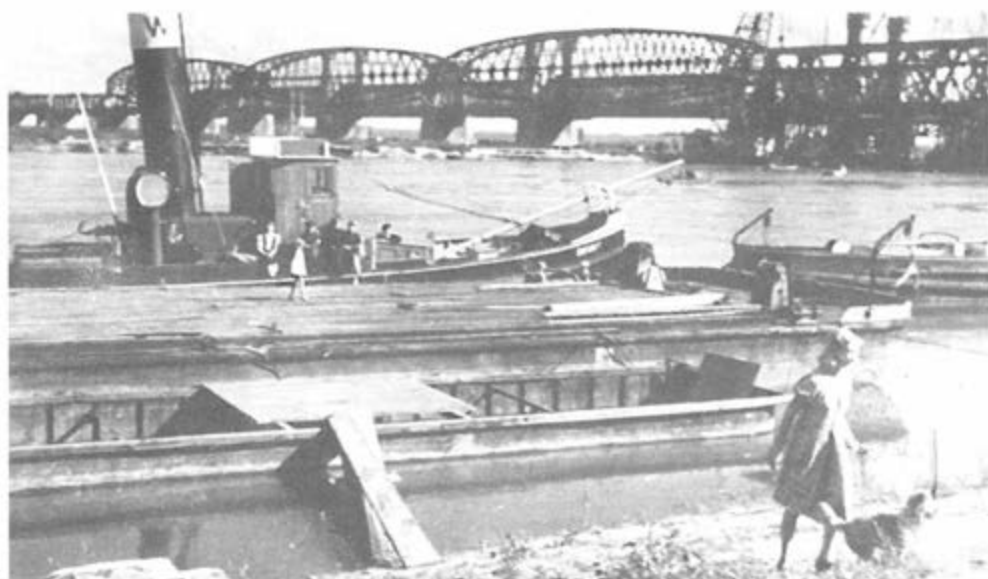
Blick auf die Weichselbrücke in Dirschau
