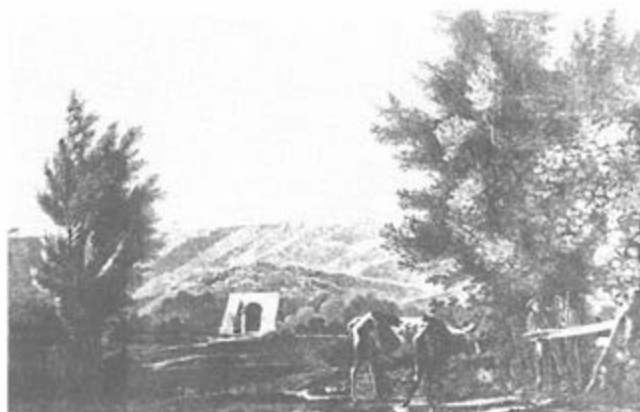
Georgensdorfer Gewölbe und der Mühlengraben
