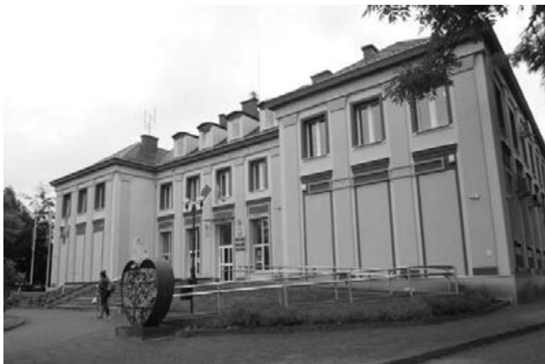
das Landratsamt in Stuhm in der Hauptstraße (ul. Mickiewicza 31)
