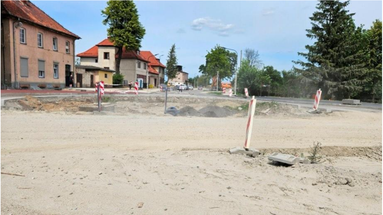
Foto 7: die Straße am Bahnhof wird komplett umgebaut
