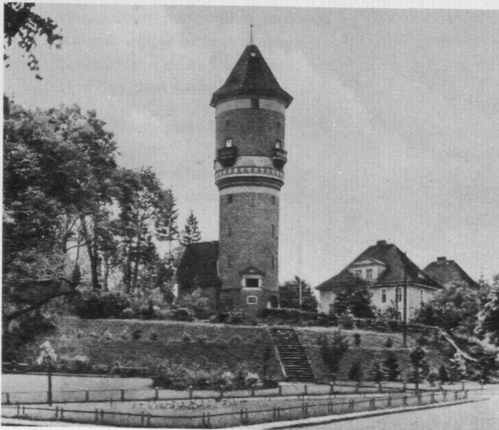
Stuhm / Westpreußen Wasserturm
