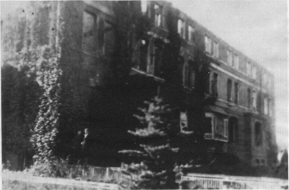
Kreiskrankenhaus nach der Zerstörung im Jahr 1945
