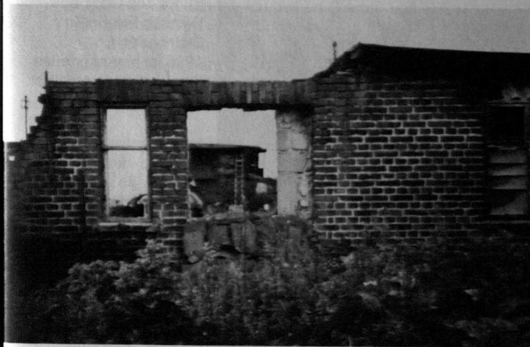
Verfallener Bauernhof von Margarete u. Bruno Blank. Im Vordergrund der Rest des Wohngebäudes (Gartenansicht).
