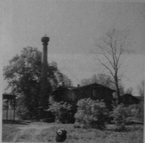
Gutshaus Ziehm in Troop - Mai 1998 -. In diesem Gebäude befand sich auch die Inspektorwohnung. Der Schornstein gehörte zur früheren Brennerei der Storch hat auch heute noch sein Domizil dort.
