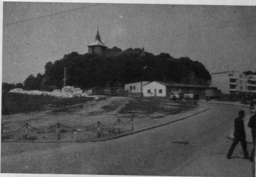
Der Wiederaufbau des Marktes 1972. Die kath. Kirche vor dem Schloßberg.
