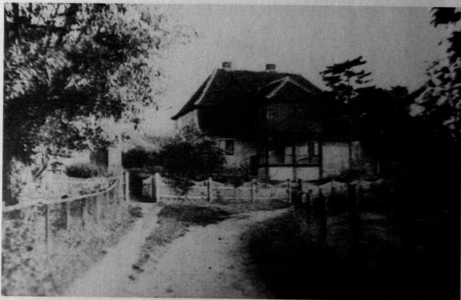
Vorlaubenhaus, das „Henkerhaus“ am Ende der Feldstraße in der Nähe des Galgenberges. Erbaut etwa 1724, es wurde nach 1945 abgerissen.
