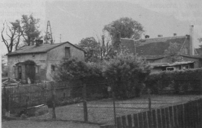
links Haus von Kaminski; dahinter die Schule von Stuhndorf
