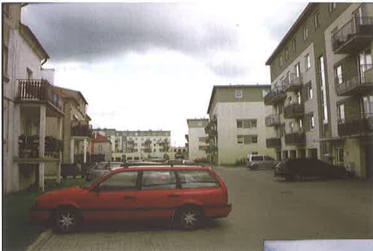
Ansicht der „Osiedle Przemysłowa“ im Westen der Stadt
