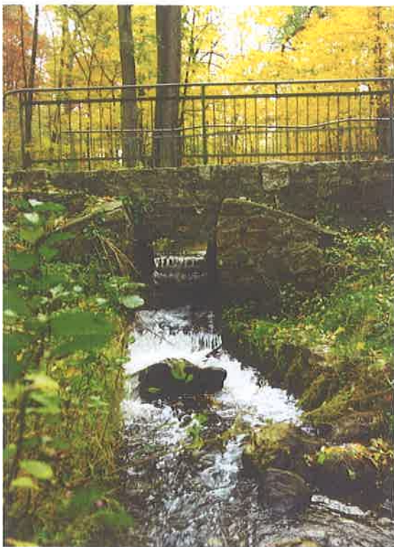
Kleine Brücke über dem Cedron Fluss in Neustadt (Wejherowo)
